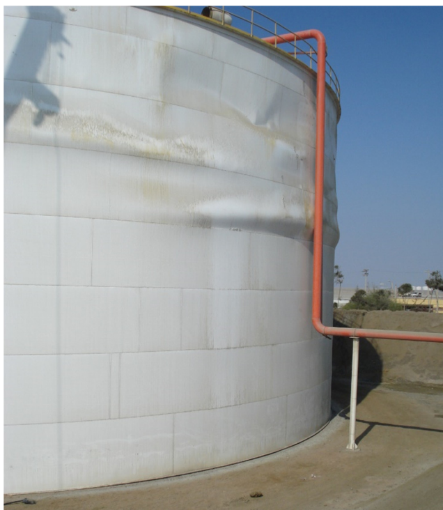
Figura I-1. Falla tipo rodilla de elefante en estanques de acero para contención de líquidos
